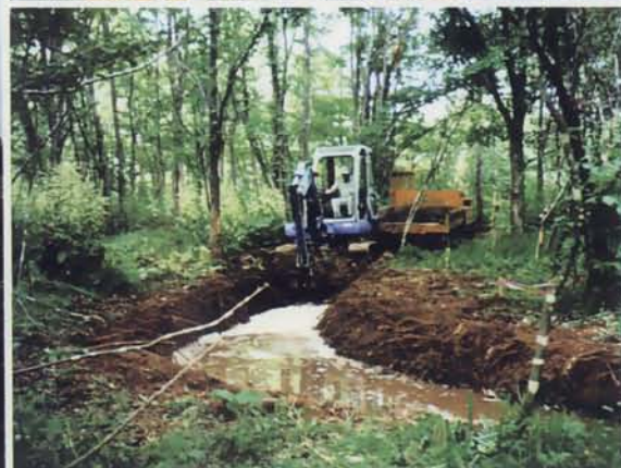
左：低水護岸のブロックを敷設してから土で覆っている。ブロックの敷設作業は川側から行い、陸部の林の伐開範囲を減らした。右上：完成後2年目の現場の様子。右下：護岸で遮断された湧水路と本流の生態系を連続させるために、護岸端の上流側に素掘りの水路を造っている (66ページまでの写真：特記以外は伊豆倉組)
