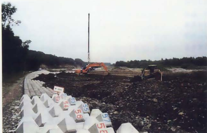
左：低水護岸のブロックを敷設してから土で覆っている。ブロックの敷設作業は川側から行い、陸部の林の伐開範囲を減らした。右上：完成後2年目の現場の様子。右下：護岸で遮断された湧水路と本流の生態系を連続させるために、護岸端の上流側に素掘りの水路を造っている (66ページまでの写真：特記以外は伊豆倉組)
